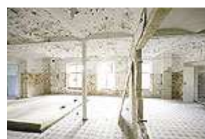
Rohbau - Renovierung der Küche
